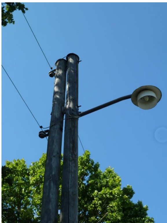
Størstedelen af Albertslund Kommunes belvningsanlæg er nedslidt, utidssvarende og har lav energieffektivitet.
